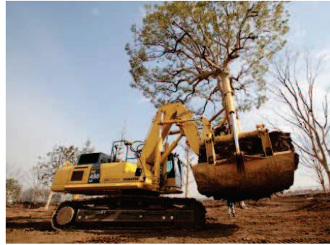
大径木移植 場内移植
